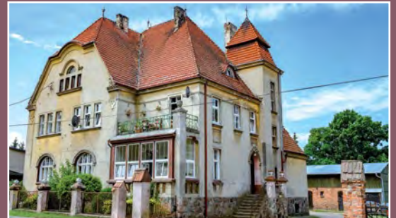
Budynek dawnego urzędu dystryktu we Wieleniu Ehemaliges Distriktamt Gebäude in Filehne
