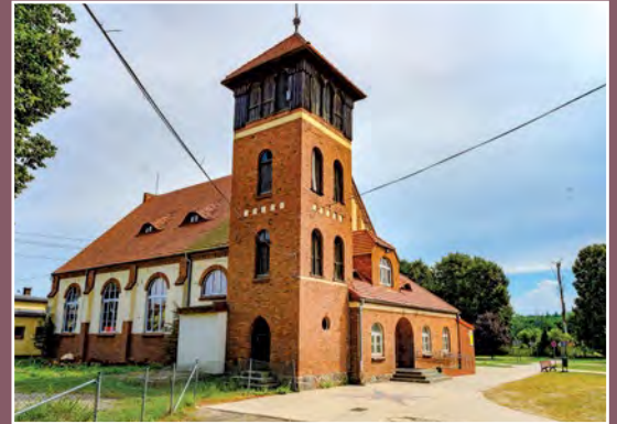
Sala gimnastyczna z wieżą pożarową we Wieleniu Turnhalle mit Feuerwehrturm in Filehne
