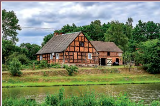
Szachulcowy dom w Dębogórze Fachwerkhaus in Eichberg
