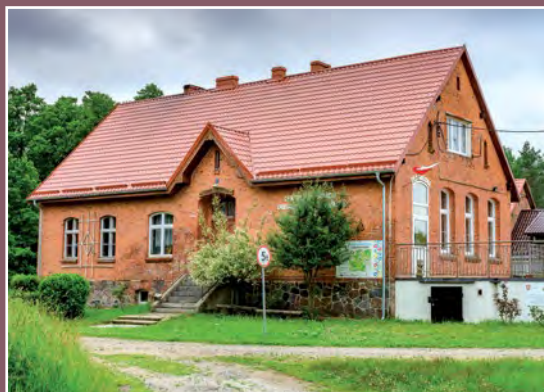
Dawna szkoła w Kuźniczce Ehemalige Schule in Kottenhammer
