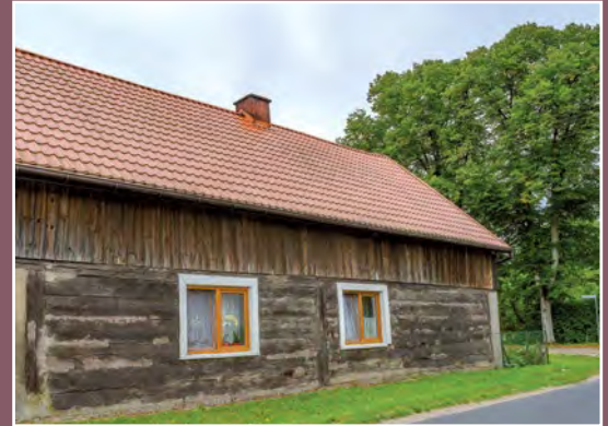
Drewniany dom w Kocieniu Wielkim Hölzernes Haus in Groß Kotten
