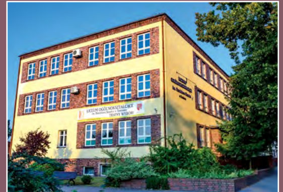
Modernistyczny gmach LO w Trzciance Modernistisches Gebäude des Lyzeums in Schönlanke
