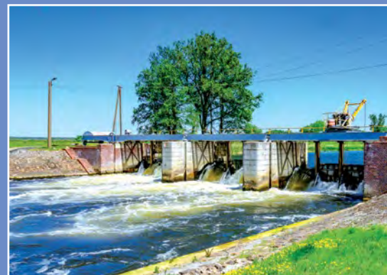
Jaz na Noteci Stauwehr an der Netze
