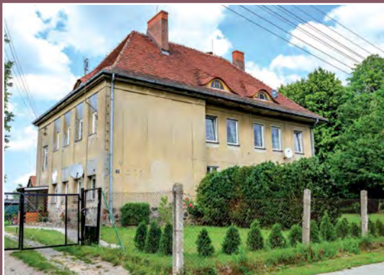
Szkoła w Runowie Schule in Runau
