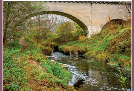
Dawny most kolejowy w Zabrodziu Alte Eisenbahnbrücke in Gramattenbrück
