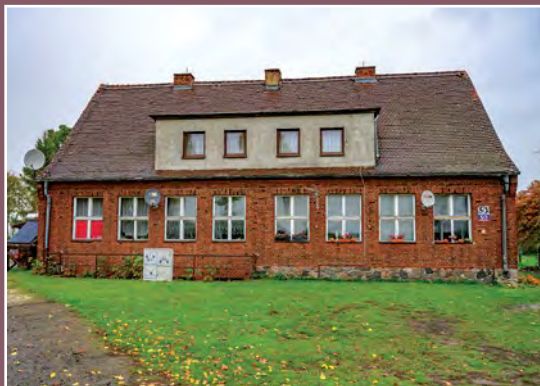
Dawna szkoła w Skrzatuszu Ehemalige Schule in Schrotz
