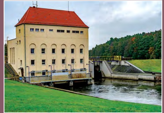
Elektrownia w Dobrzyca Elektrizitätswerk in Borkendorf
