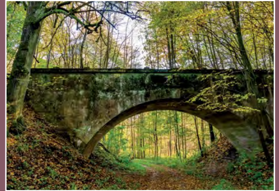
Most kolejowy w Żelichowie Eisenbahnbrücke in Selchow
