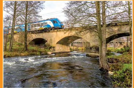
Most kolejowy w Łokaczu Wielkim Eisenbahnbrücke in Lukatz
