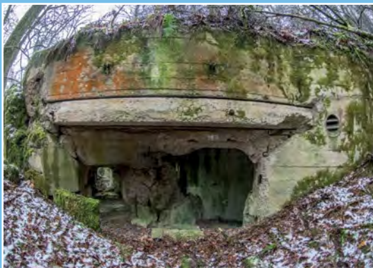
Bunkier koło Bielic Nowych Bunker bei Neu Beelitz
