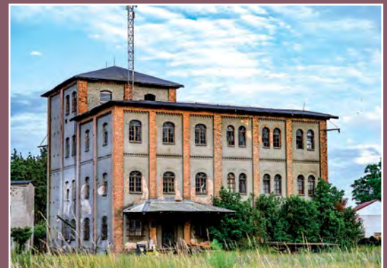
Dawny młyn w Hucie Szklanej Ehemalige Mühle in Glashütte
