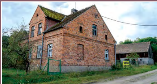
Dom w Przesiekach Haus in Prossekel
