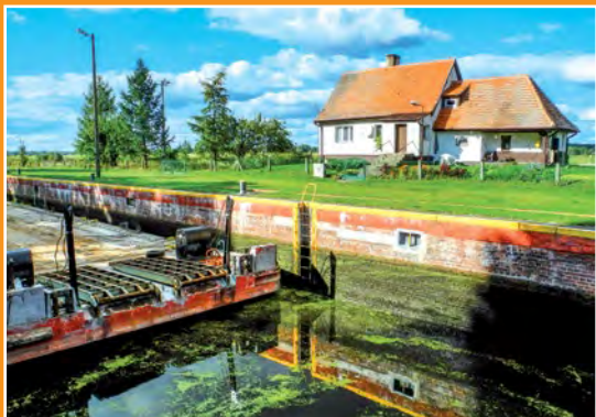
Noteca śluza Netzeschleuse
