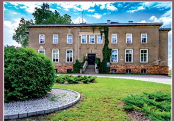
Pałac w Oleśnicy Palast in Oelsnitz
