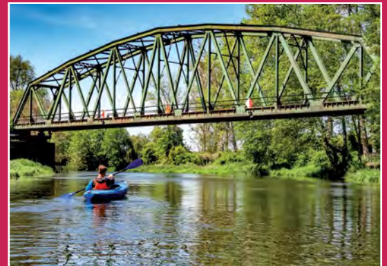
Most kolejowy w Ujściu Eisenbahnbrücke in Usch
