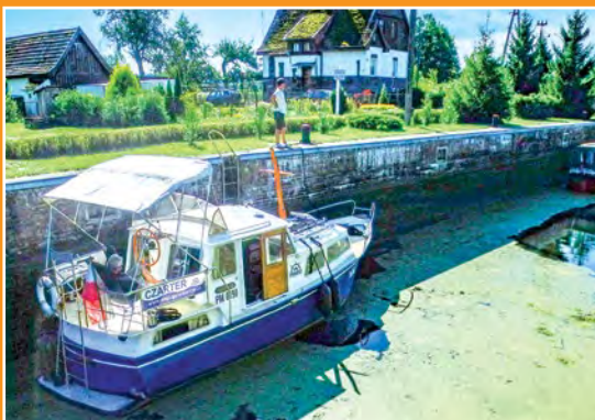
Śluza Romanowo Schleuse in Romanowo
