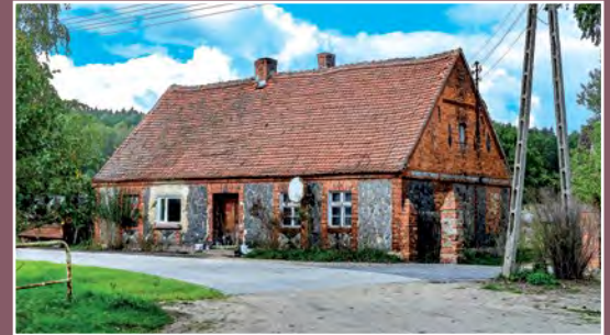
Dom z polnych kamieni i cegły Haus aus der Feldsteinen und Ziegeln
